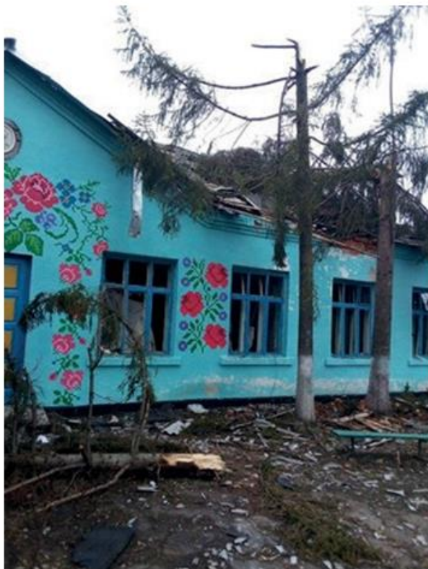
Фото 1. Зруйнована будівля Грабівського будинку фольклору
