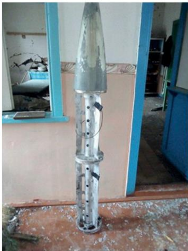
Фото 2. Зруйнована будівля Грабівського будинку фольклору
